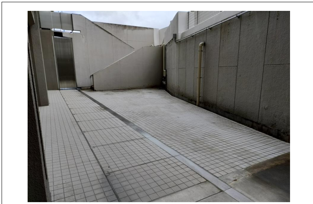
③ 屋外スペース東側
