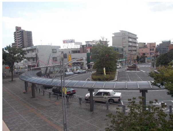
市道第3198号線 (戸田公園駅西口駅前交通広場)
