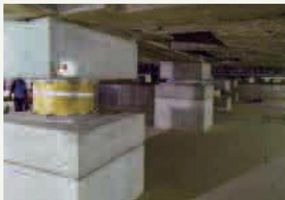
戸田市役所庁舎耐震改修で地下に設置された免震装置
