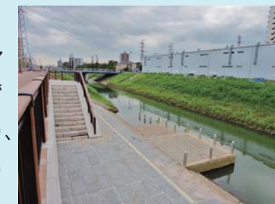
改修された護岸（県による別途事業）
