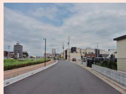
交付金により整備した道路
