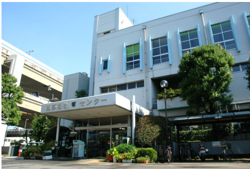
図 施設の外観
