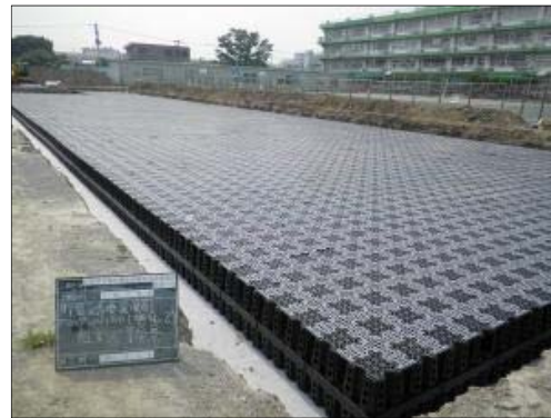
図3-24 浸透施設の設置工事
