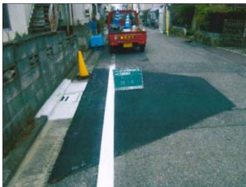
図3-23 道路の浸透枳の設置
