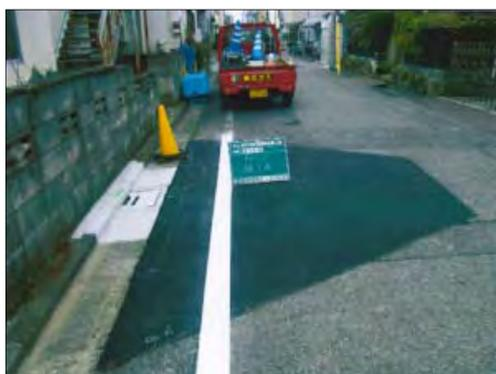
図3-23 道路の浸透柵の設置
