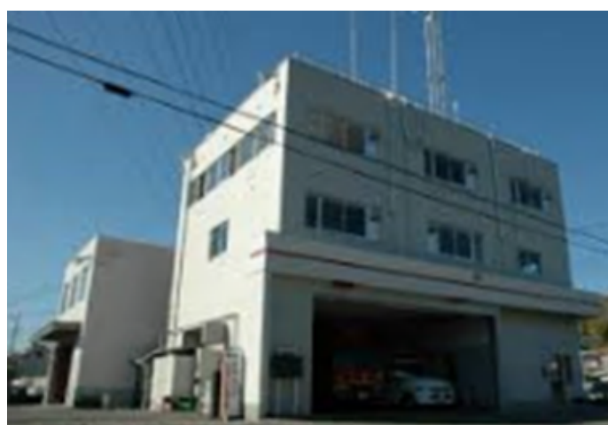
(西部分署庁舎)
