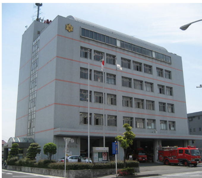
(消防本部庁舎)
