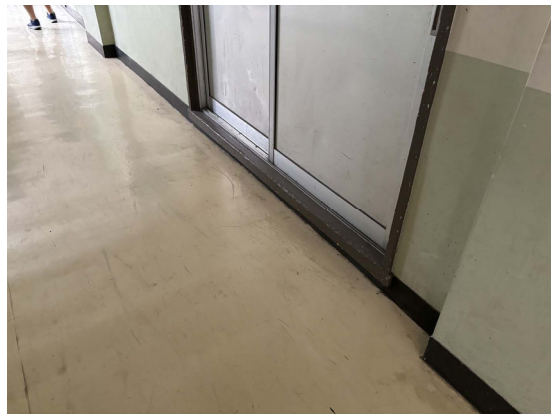
教室棟 教室出入口 令和6年6月撮影
