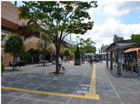
市内で整備されたバリアフリー歩道
