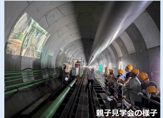
雨水貯留管の内部
