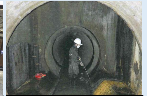
マンホール内部状況
