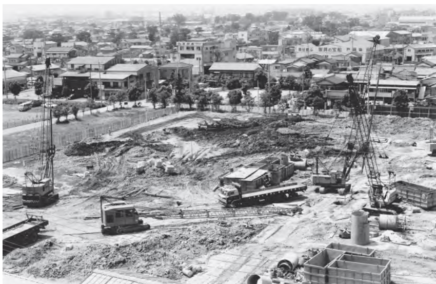
文化会館建設 昭和54年(1979)
