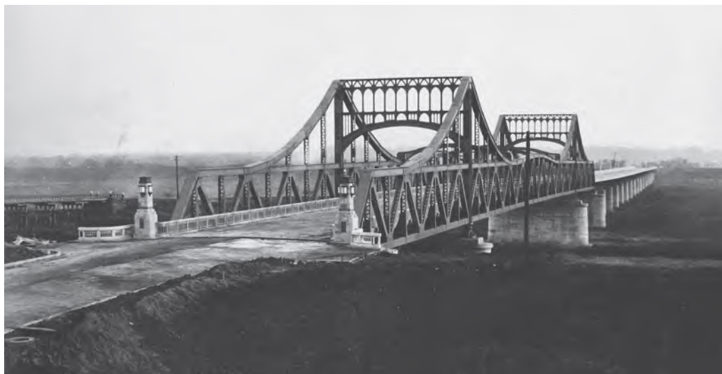
鉄橋戸田橋（3代目） しょうわ 昭和7年(1932)
