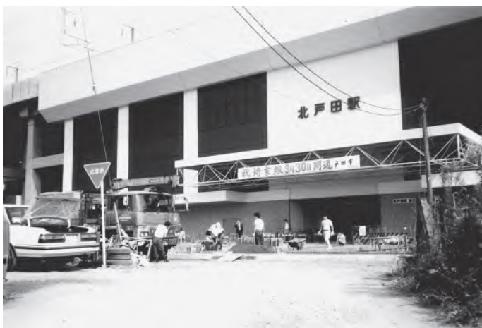
埼京線北戸田駅 昭和60年(1985)
