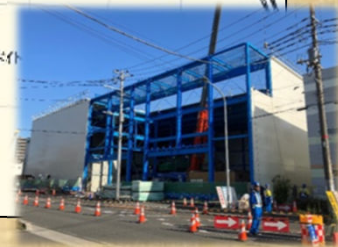
令和5年度施工状況
