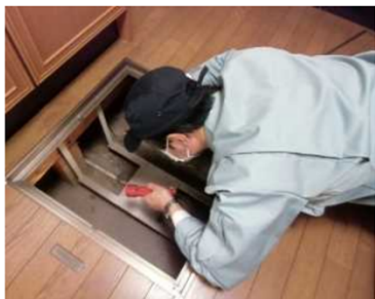
「土台・床組、基礎」調査の様子
