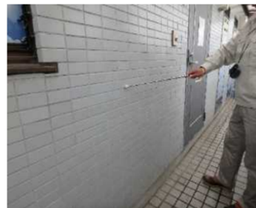
「外部（外壁）」調査の様子
