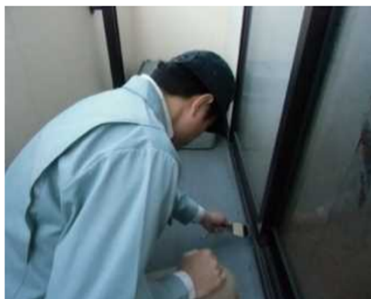
「外部（バルコニー）」調査の様子
