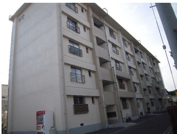
外壁の状況（北側）
