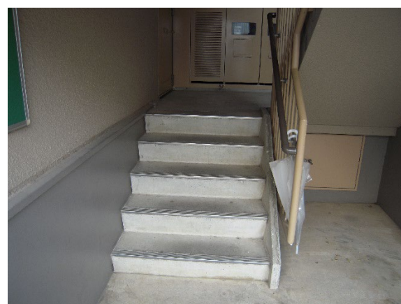
階段室の状況
