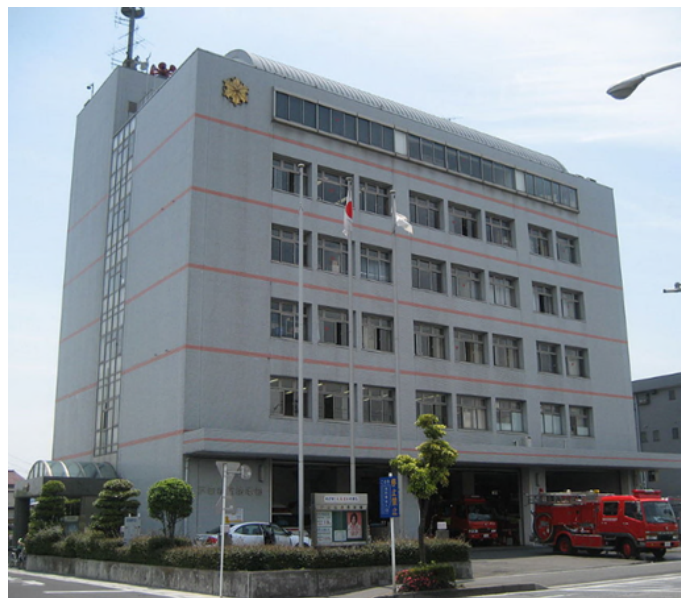
(消防本部庁舎)
