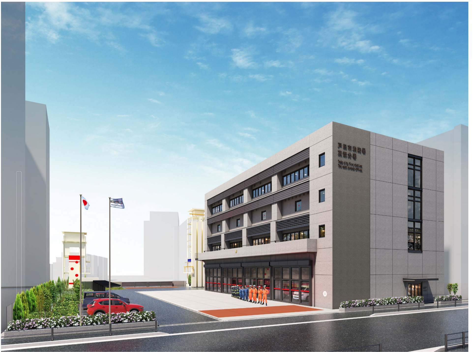
東部分署庁舎改築等工事 外観 2024/2/15 二校
