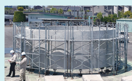
セグメントの仮組み状況
