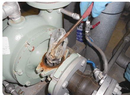
ポンプ施設につまった異物を取り除いています
