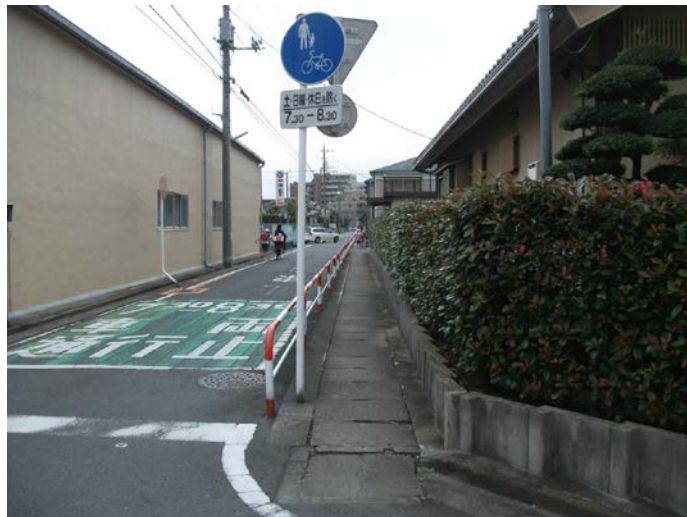
図 交通規制やガードレール設置等による通学路の安全対策
