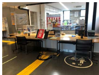
△誘導用ブロック上に物が置かれている
