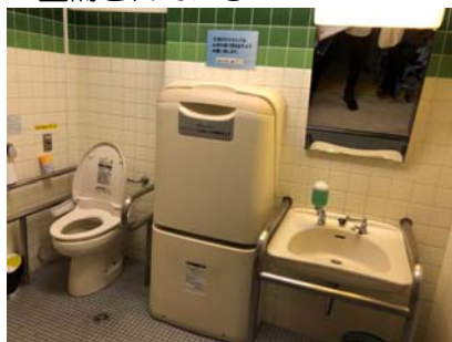
△空間が狭く、ベビーベッドなどで車いすで便器に近づきにくい
