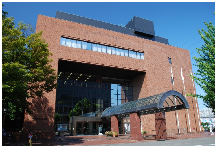
図 戸田市文化会館（改修工事前）
