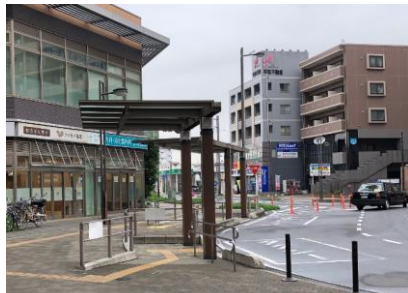
◎タクシー乗り場の段差がスロープにより解消されている
