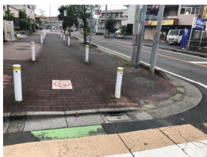
△歩車道境界の段差が大きい 誘導用ブロックがなく車止め に衝突するおそれがある
