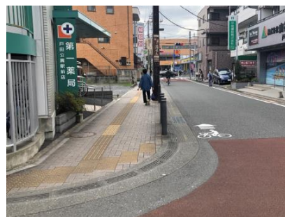
◎セミフラット構造の歩道で、 歩車道境界にも段差がなく、 平坦で歩きやすい
