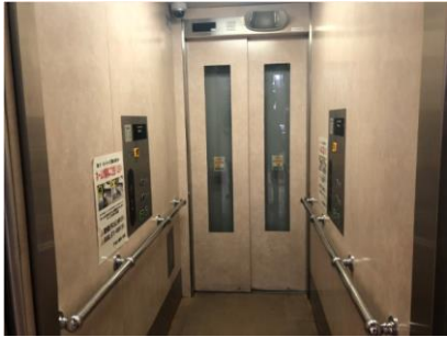
◎スルー式のエレベーターは車いす使用者等が転回する必要がなく利用しやすい
