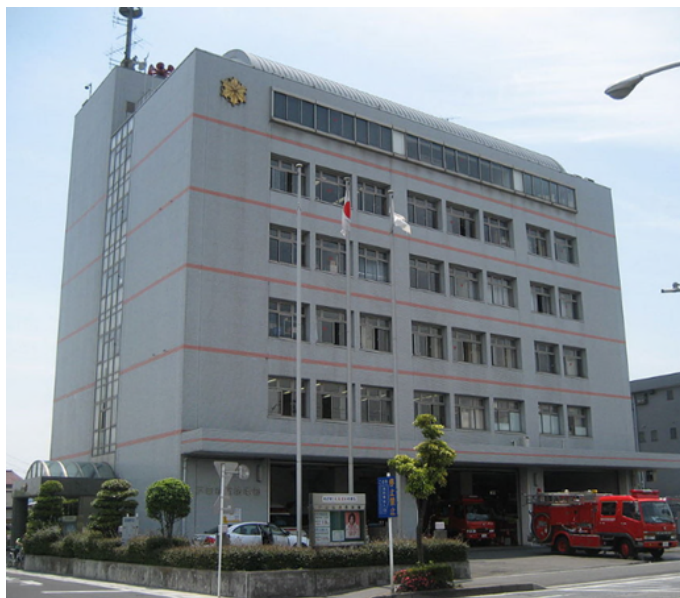
(消防本部庁舎)
