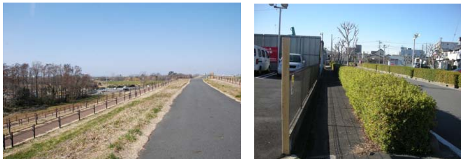
写真5-11 道満コース（荒川堤防上、美女木6丁目周辺）
