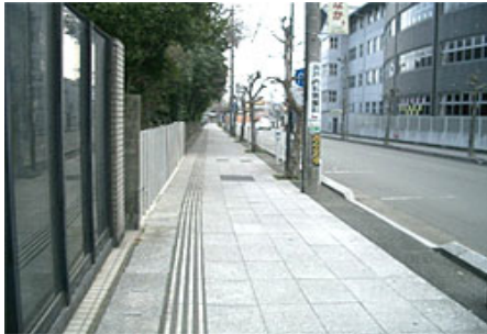
写真3-1 セミフラット形式歩道
