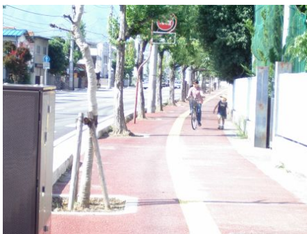
写真3-2 フラット形式歩道
