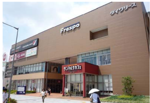
駅前の商業施設で屋上利用広告物の設置を制限している
