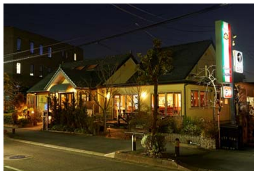
暖かみのある光源を用い、夜間景観を演出している。 (戸田市)
