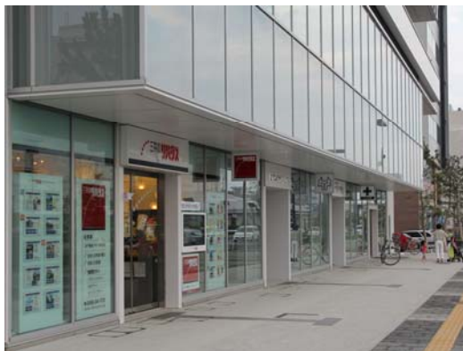
店舗間で屋外広告物の規格を揃えた商業・業務ビル
