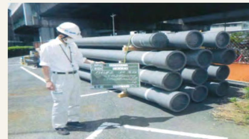
①埋設前の配水管
