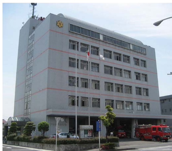
(消防本部庁舎)
