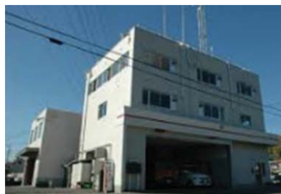
(西部分署庁舎)
