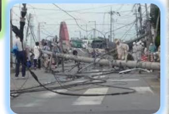
越谷市における竜巻による電柱倒壊 埼玉県無電柱化推進化計画より引用
