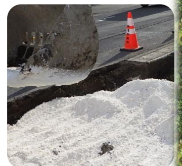
路床改良材の石灰を撒いている
