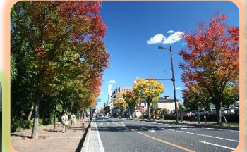
市役所南通り 無電柱化の風景
