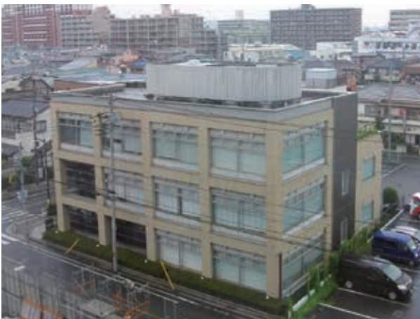
屋上設備を遮へいし、屋上をすっきりとさせている。(戸田市)
