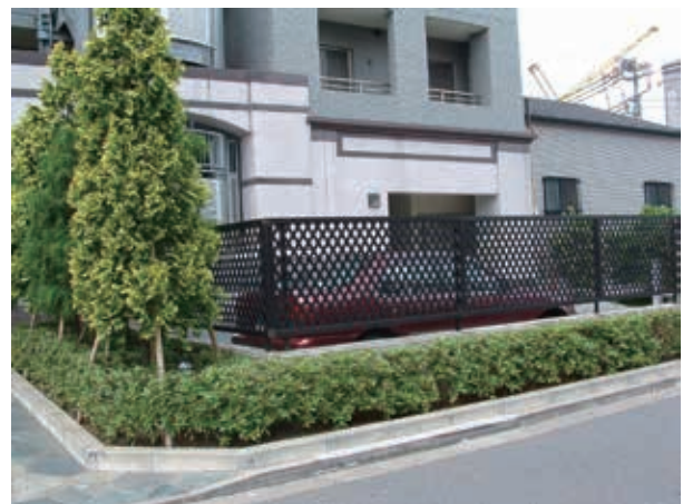
景観に配慮した柵と緑化によって修景している。
