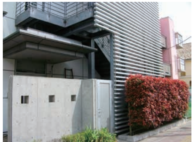
屋外階段を遮へいして、通りの景観に配慮している。
