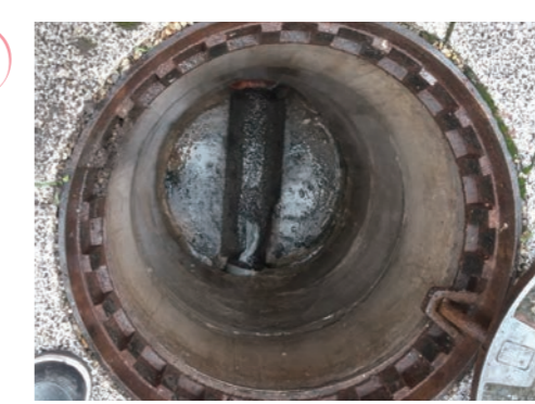
マンホール清掃後
