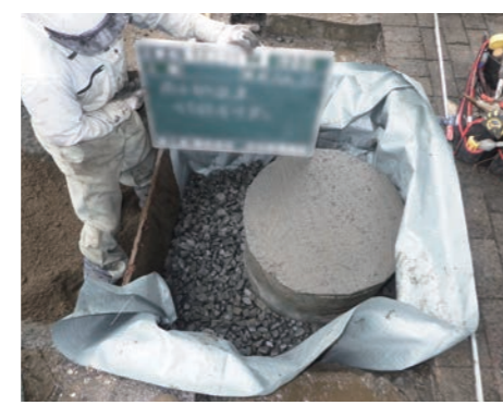
浸透桝の設置
