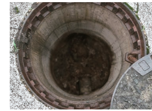
マンホール清掃前
