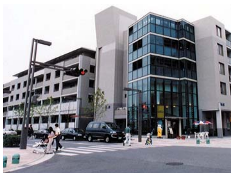
段差の少ない歩道により、ベビーカーなどの通行がスムーズとなっています。
