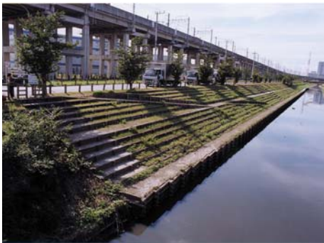
道路沿いの散策路の他、水辺に近づくる場所を設けています。
