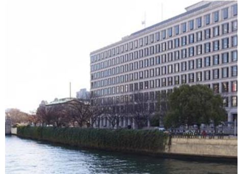
ツタによって護岸を緑化しています。
