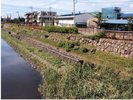
木杭など自然素材を活かした護岸です。
