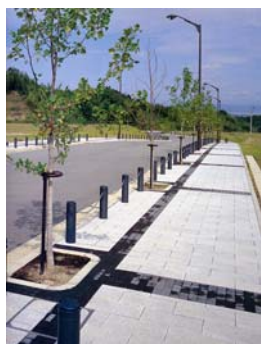
凹凸の少ない舗装材と明度差を利用した点字ブロックを採用しています。
