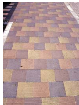
細かい溝を設けることにより滑りにくさに配慮しています。
