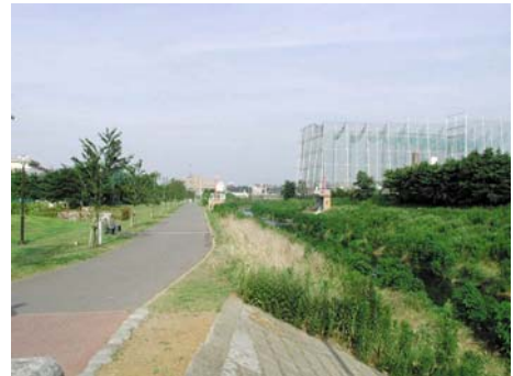
管理用通路を遊歩道とし、隣接する公園と一体化を図っています。
