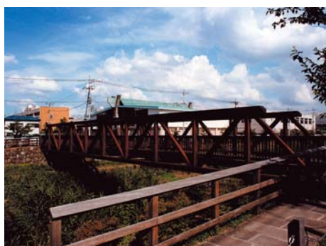
多自然型工法による河川改修に合わせ、木橋（人道橋）としています。
