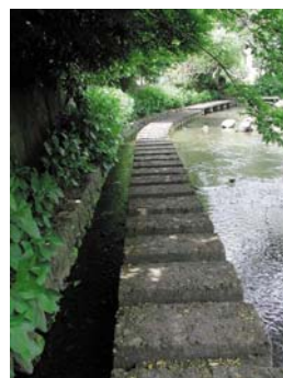
多孔質ブロックを用いて水質浄化を図っています。
