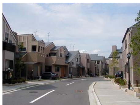
電線を地中化し、すっきりとした街並みを実現しています。
