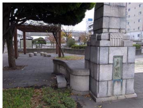
かつてあった橋梁の親柱と高欄の一部を残して風景の記憶を継承しています。
