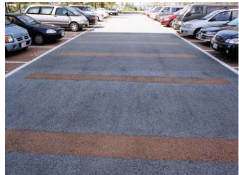
駐車場の速度低減表示に落ち着いた色使いの樹脂舗装を用いています。
