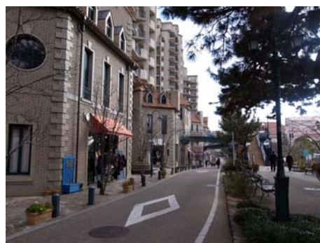
にぎわいや楽しさを感じさせる歩行者のための道としてデザインしています。
