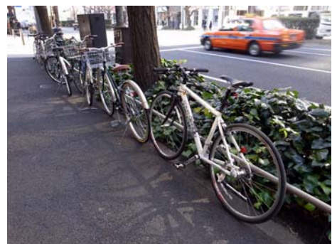
歩行者の邪魔にならないよう整然と駐輪できる設備を設置しています。
