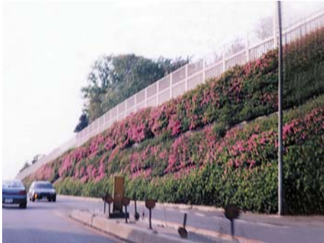
緑化ブロックの樹木が生育し、構造物を覆って背後の緑ともつながっています。
