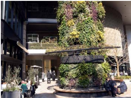
建物の柱に直接植栽を施して緑化しています。
