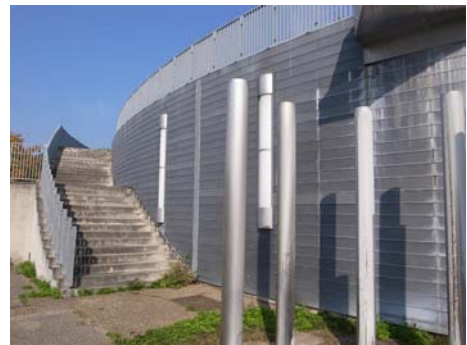
金属板により擁壁面を建築的に修景しています。
