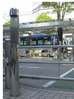
障害者の誘導のためのインターホンを設置しています。
