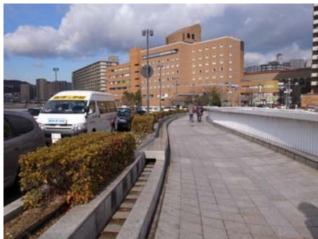
橋上に植栽帯を設けて緑化しています。
