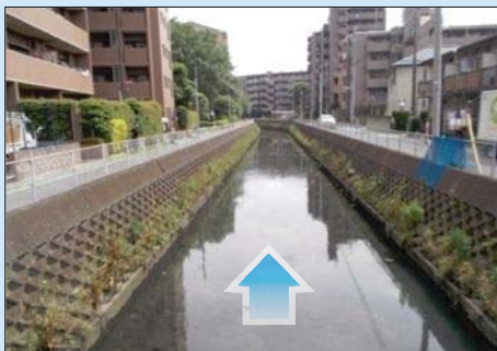
下流部(合流点～二枚橋):暫定改修済み区間
