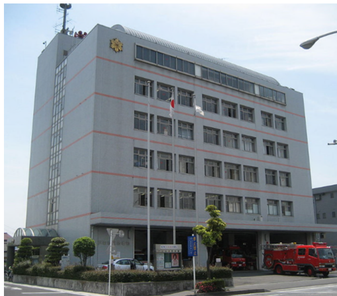
(消防本部庁舎)
