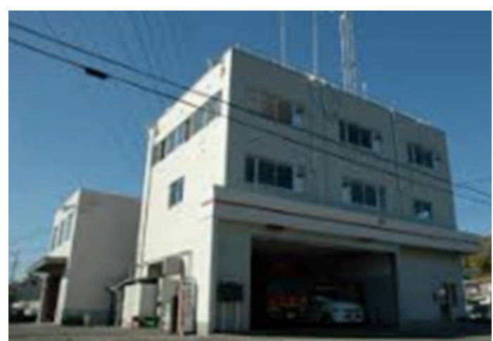
(西部分署庁舎)
