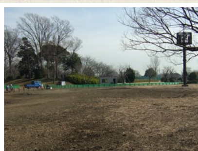
2010年の造成工事中
