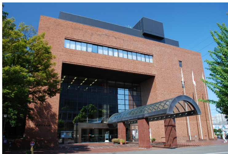
図 戸田市文化会館（改修工事前）
