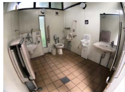
◎大型ベッドやオストメイト対応流し台が設置されている
