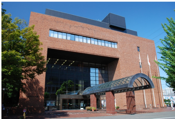
図 戸田市文化会館（改修工事前）
