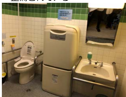
△空間が狭く、ベビーベッドなどで車いすで便器に近づきにくい
