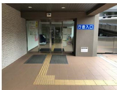
◎出入口への誘導用ブロックや音声案内、自動ドアにより利用しやすい
