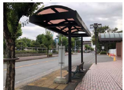
△バス停留所に誘導用ブロックが過剰に設置されている
