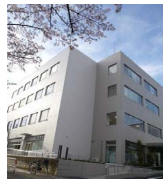
新曽南庁舎・新曽南多世代交流館
