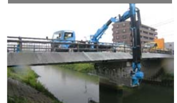
橋梁の点検状況
