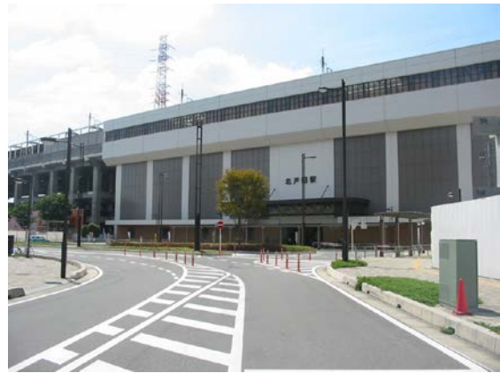
土地区画整理事業により整備が行われた 北戸田駅東口
