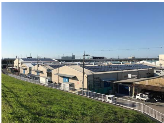
堤防上から望む倉庫群
