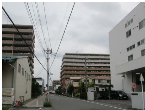
様々な規模と用途の建物が混在するまち並み
