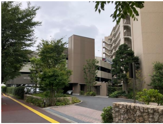
立体駐車場を、建物と調和するデザインとし、色彩を分節化して表情を豊かにしている。(I-2-1の例)
