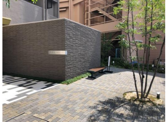
歩行者が一休みできるような小広場や通り道等の創出に努めている。(E-2-2の例)
