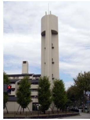
給水塔を建物と調和したデザイン・色彩としている。(I-2-1、I-2-2の例)
