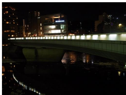
高欄越しの端正で控えめな明かりにより橋梁の構造をおだやかに演出している。(J-1-3の例)
