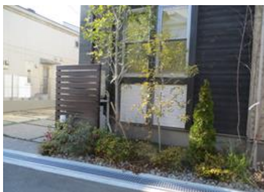
屋外空調機を、通りから見えにくい場所に設置している。(D-1-5の例)
