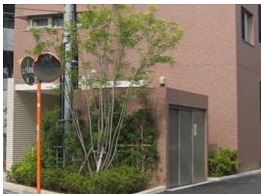
ゴミ置き場を、建物と一体的な上屋を設ける、緑でカバーする等の修景をしている。(D-1-1の例)
