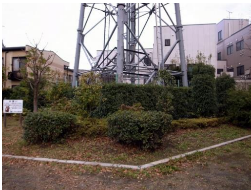
公園敷地内の送電鉄塔の足元に植栽を配置している。
