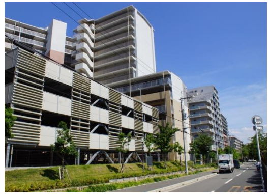
立体駐車場を、外観意匠や色彩等を工夫し建物と総合的にデザインしている。(D-1-7の例)
