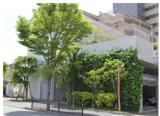
立体駐車場は壁面の分節化や低層部の仕上げ材の工夫、緑化修景等によって周辺の建物との違和感がないように気をつけている。（B-9-2、B-9-3の例）
