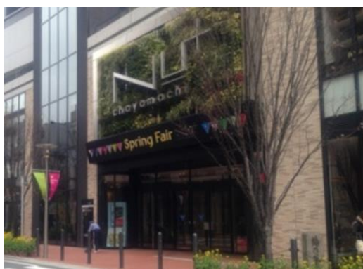
建築壁面を部分的に覆うような植栽を工夫している。(B-2-3の例)
