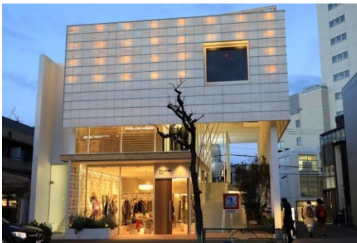
建物全体を照らすのではなく、壁面の間接照明を用いたり照明器具の設置高さを工夫するなど建物の大きさを感じさせないよう配慮している。(G-1-4の例)
