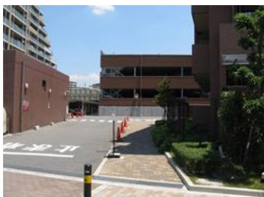
立体駐車場を、建物と調和するデザインとし、色彩を分節化して表情を豊かにしている。（I-1-1の例）
