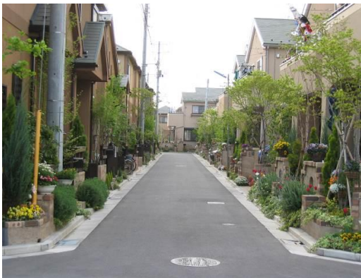
通りに面したオープンスペースや植栽を設けている。(E-1-1の例)
