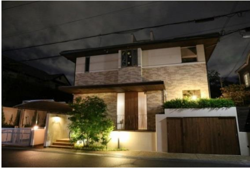
玄関周りや敷地外周部に照明を配置し、やすらぎのある夜間景観の演出に努めている。(G-1-2の例)
