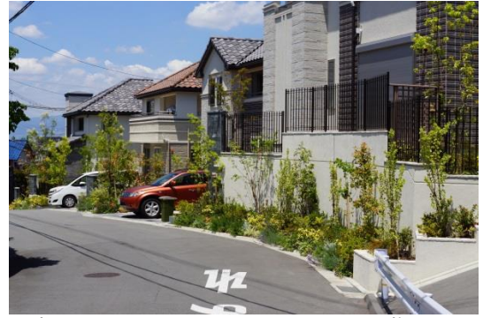
擁壁の前面や上部に植栽を行い、構造物の圧迫感を低減させている。(E-1-5の例)
