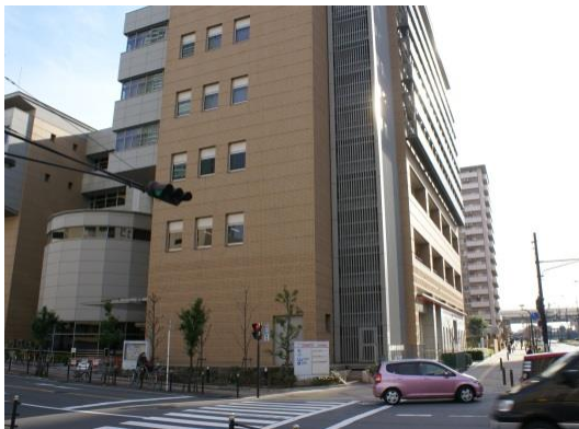
外階段は、ルーバーで覆う、建物の一部に取り込む等の修景をしている。(D-2-1の例)
