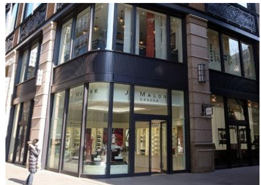
店舗の構造体や開口部をアクセントとなるよう色彩に配慮し、にぎわいを演出している。(B-6-1の例)
