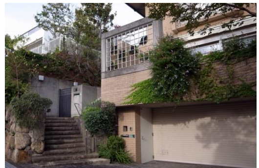
ベランダや目線より高い場所に、緑化を行い立体的な緑を見せている。（B-5-2の例）
