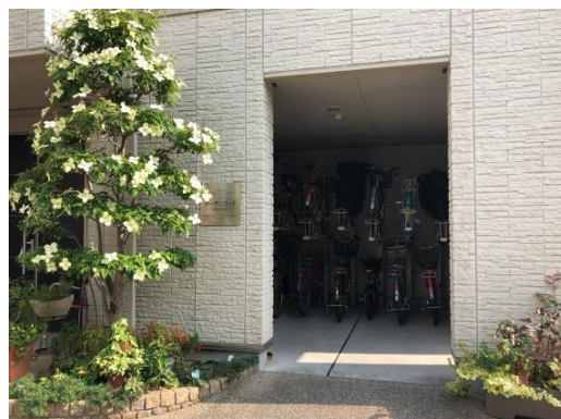
駐輪スペースを建物の一部として取り込んでいる。(D-1-1の例)
