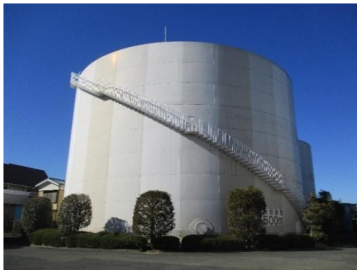
色彩を塗り分けることにより圧迫感を軽減したタンク (I-3-2の例)
