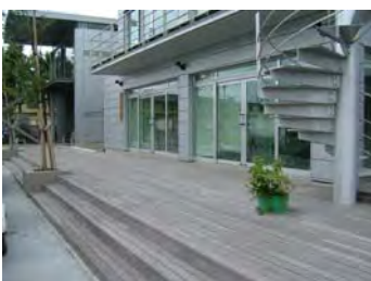
ウッドデッキによる工夫した例
