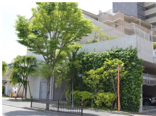
事例34 立体駐車場は壁面の分節化や低層部の仕上げ材の工夫、緑化修景等によって周辺の建物との違和感がないように気をつけている。
