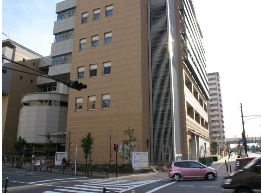
事例46 外階段は、ルーバーで覆う、建物の一部に取り込む等の修景をしている。
