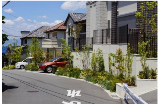
事例 52 擁壁の前面や上部に植栽を行い、構造物の圧迫感を低減させている。
