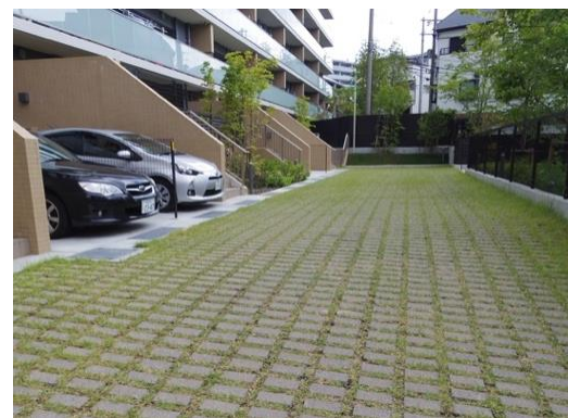
事例 58 青空駐車場の場合、芝ブロック等により舗装面を目立たせないようにしている。
