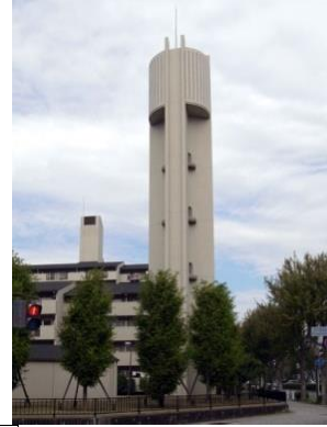
事例74 給水塔を建物と調和したデザイン・色彩としている。
