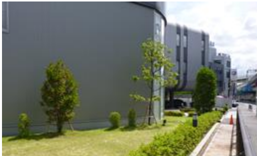
事例14 大規模な壁面は、雁行させたり色彩に変化をつけるなど、単調な連続を避けている。
