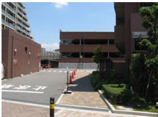
事例33 立体駐車場を、建物と調和するデザインとし、色彩を分節化して表情を豊かにしている。
