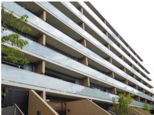
事例21 ベランダで、不透視性の手すりやスクリーンを採用する等の配慮を行っている。
