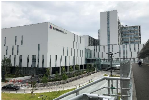
事例 28 壁面にスリットを設け、親しみやすさを生み出すよう工夫している。
