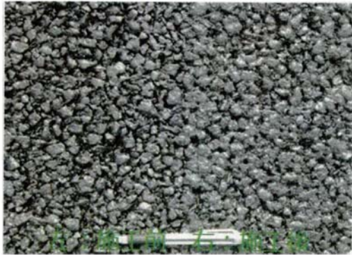
透水性舗装の例
