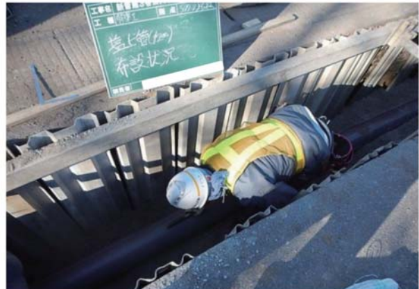
【下水道整備(汚水管渠整備)の一例】
