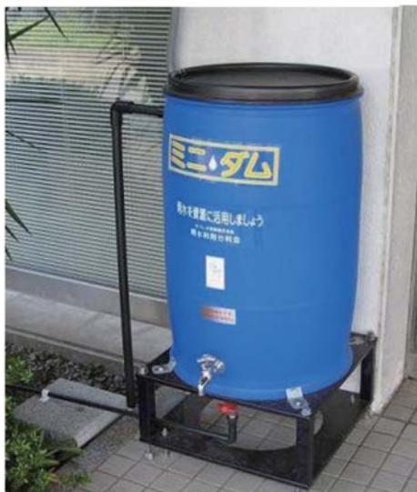
雨水貯留施設（ミニダム）
