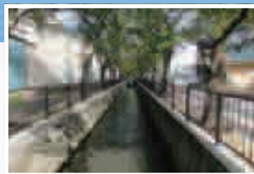
菖蒲川上流水路防護柵
