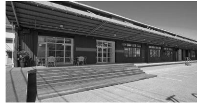
倉庫をリノベーションして創られたオフィス(D社)
