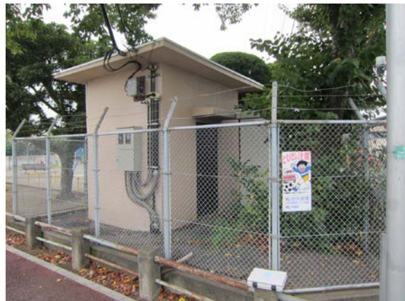
写真:取水施設(井戸)の様子
