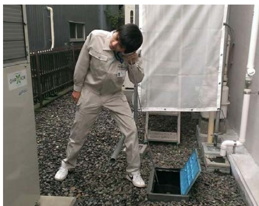
写真:漏水調査の様子
