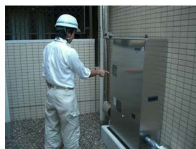
写真:増圧ポンプ調査の様子
