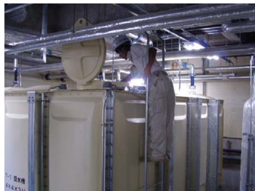
写真:貯水槽調査の様子
